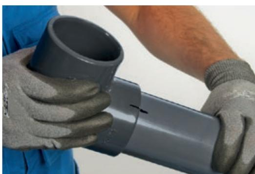
5 Segnare la corretta posizione di montaggio, una volta inserito il tubo non può più essere riposizionato (ruotato)
