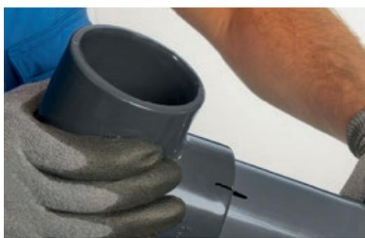
11 Montare il giunto con un movimento netto. Non ruotare il raccordo
