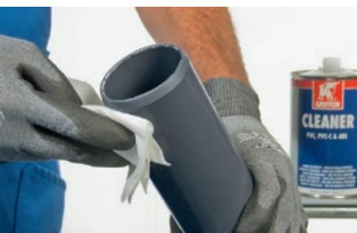
7 Pulire l'esterno del tubo con Griffon PVC Cleaner. Lasciare asciugare completamente le parti prima di applicare l'adesivo
