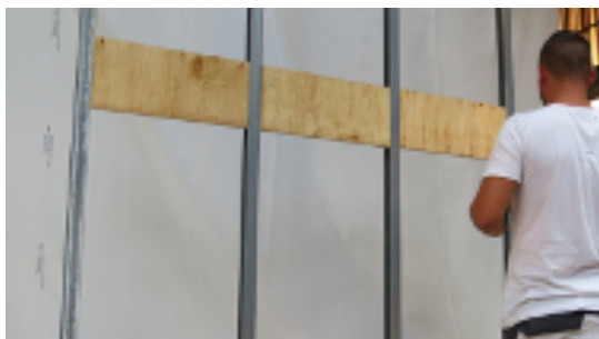
Ständerwerk aus CW 50-Profilen mit Universaltraversen
