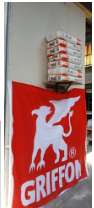
Testwand mit 150 kg Konsollast
