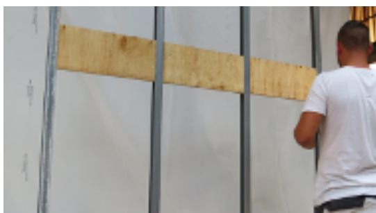
Ständerwerk aus CW 50-Profilen mit Universaltraversen
