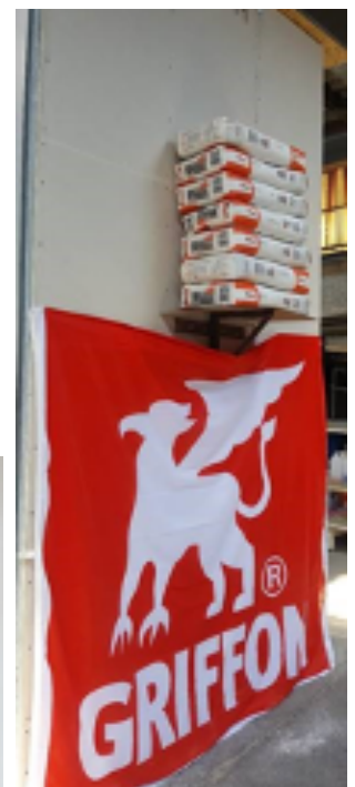
Testwand mit 150 kg Konsollast
